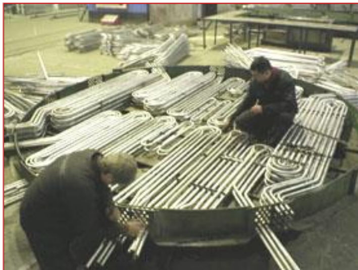
Збірка в кондуктора змієвикових елементів тарілок абсорбційних колон лінії отримання слабкої азотної кислоти
