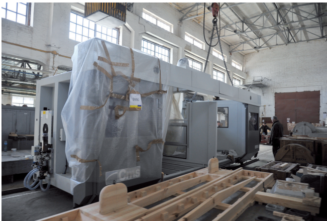
Верстат готують до встановлення в цеху
